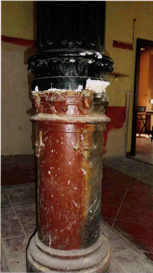
Eine von mehreren gusseisernen Säulen im Wirtschaftsraum anlässlich der Grundsanierung (2013).
