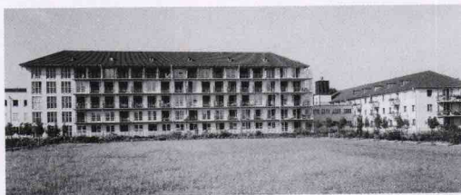
Die Südfront mit den durchlaufenden Balkonen und den zweiflügeligen Fenstertüren
